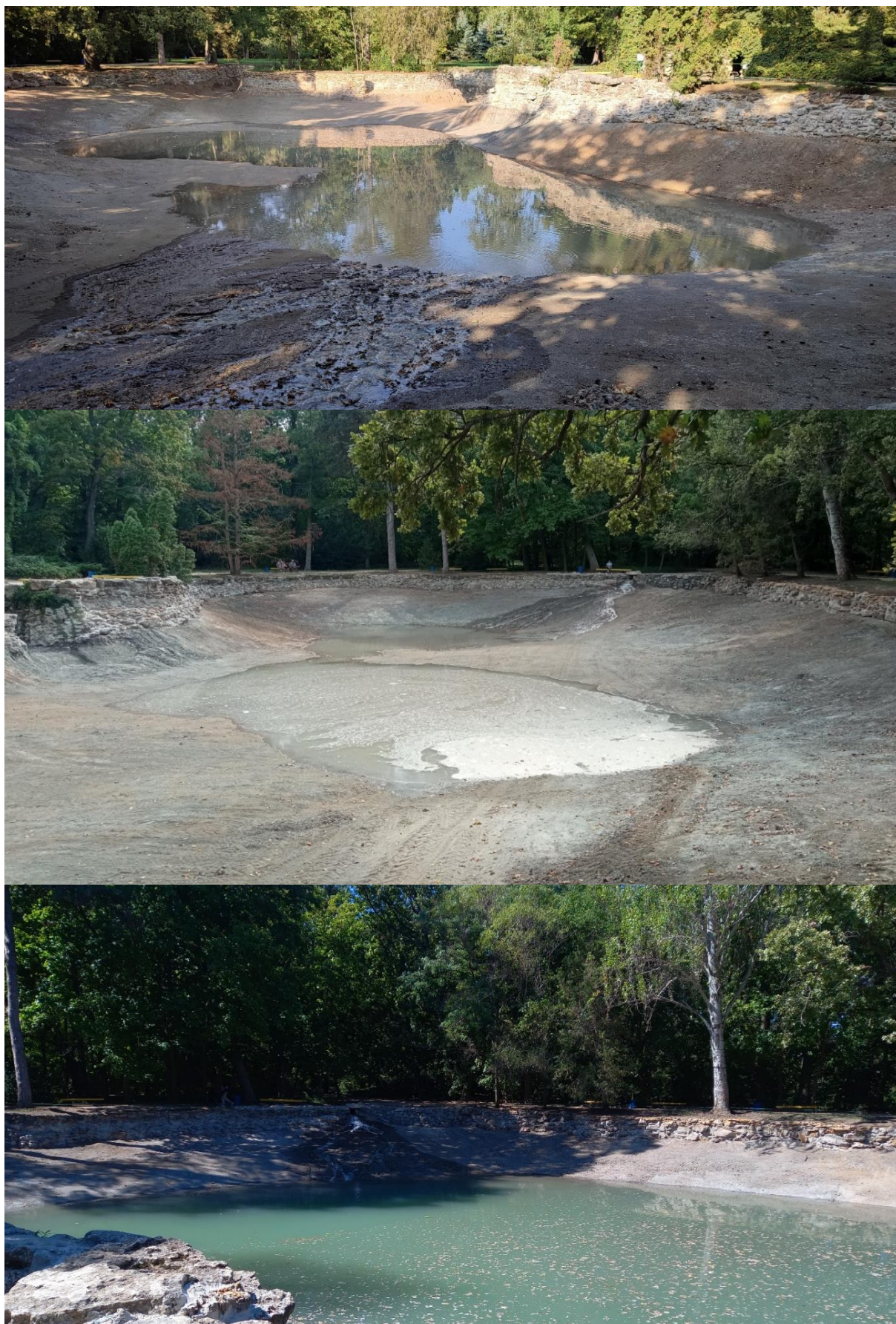
Рисунок 2.9 – Початкові етапи наповнення очищеного котловану штучного озера артезіанською водою через систему зрошувальних ариків дендропарку (фото 01.09.2022 та 03.09.2022)
