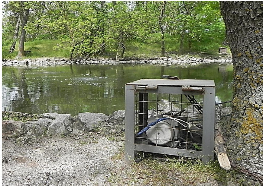
Рисунок 1.4 – Аератор на водоймі «Внутрішня»
