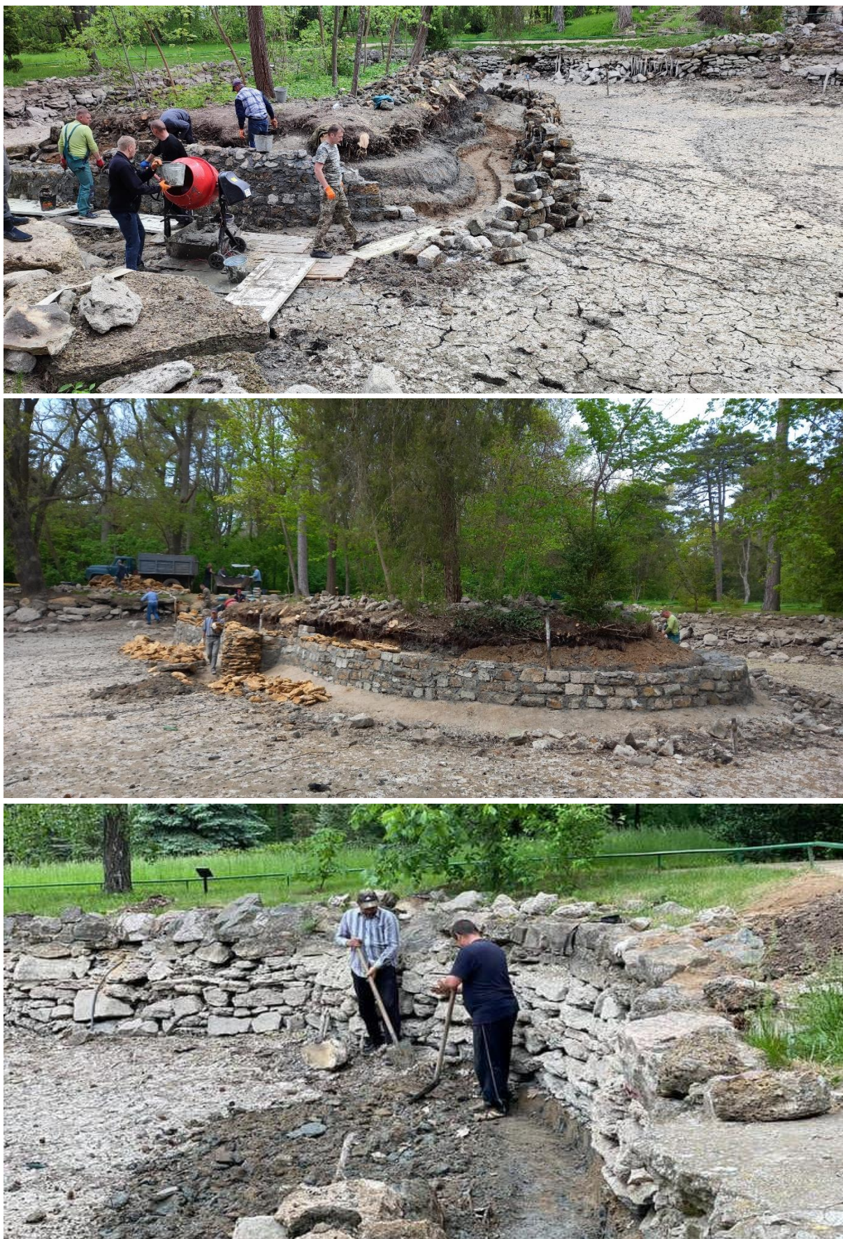
Рисунок 2.7 – Роботи з облаштування берегів озера: розчистка, підготовка фундаменту та будівництво кам'яних стін (фото 28.04.2022, 04.05.2022 та 24.05.2022)
